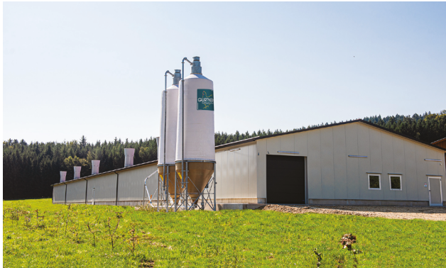
Abbildung 40: Stahlhalle mit Sandwich-Paneelen für 12.000 Freiland-LH der Firma Gurtner (© Gurtner GmbH)
