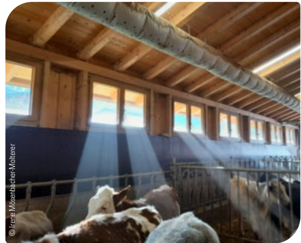
Abb. 11: Schlauchbelüftungen sorgen in Kälberställen für frische Luft
