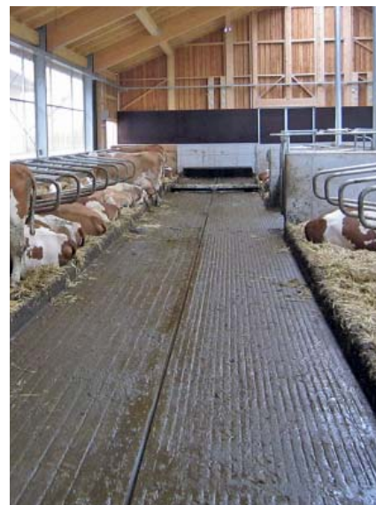
Bild 12: Rutschfeste, saubere Laufgänge sind Grundvoraussetzungen für einen guten Kuhverkehr. LK OÖ/Fruhstorfer
