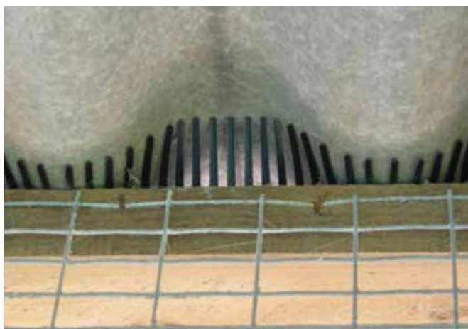
Vogelschutzmaßnahmen, Quelle: Mayringer, LK OÖ
