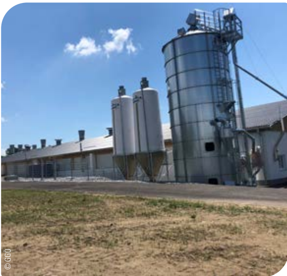
Abb. 96: Hühnerstall mit Silos
