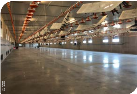
Abb. 90: Hühnerstall mit Betonboden
