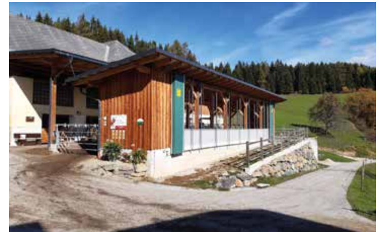
Schlichter und luftiger Zubau in Holz
