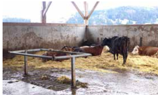
Abwurfstelle für Entmistungsroboter
