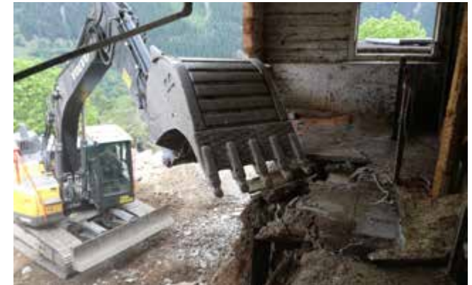
Abbrucharbeiten können sehr „tiefgreifend“ werden.
