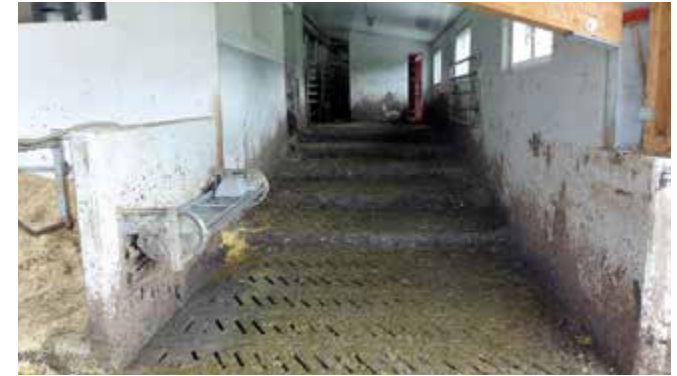
Aufgang im Inneren mit Spaltenboden mit Gummibelag
