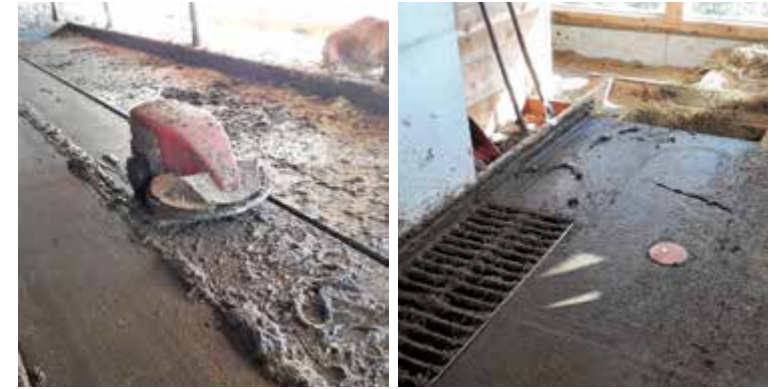
Entmistung mit Putzroboter
