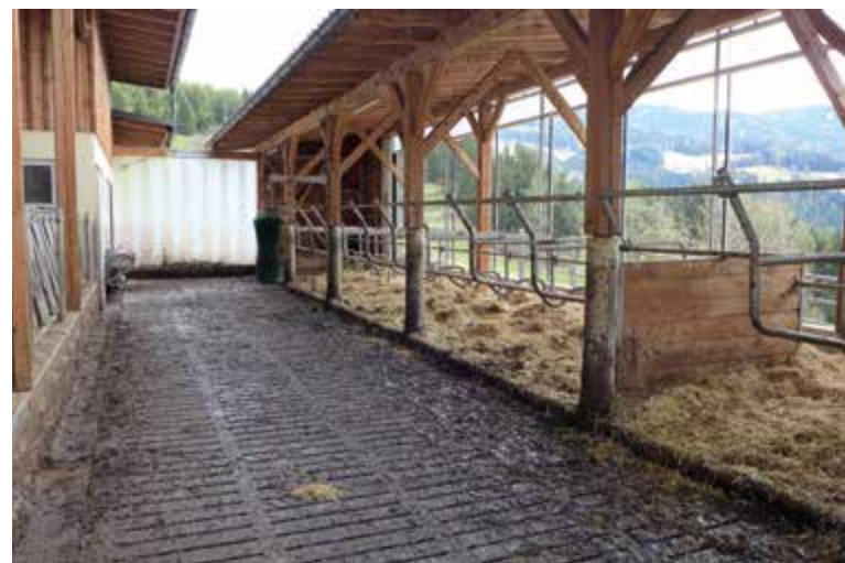
Laufgang mit darunter liegender Güllegrube
