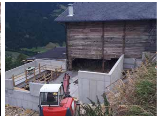
Schwieriger Unterbau für den neuen Laufstall
