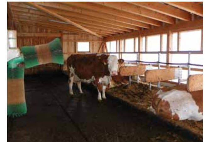
Auf Laufflächen mit 3 % Gefälle hin zu einer Harnsammelrinne sind die Ammoniakemissionen um 20 % reduziert.
