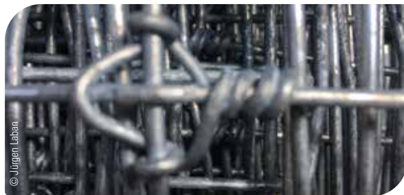
Abb 26 Zaun mit aufgesetzten und nicht-verschiebbaren Knoten
