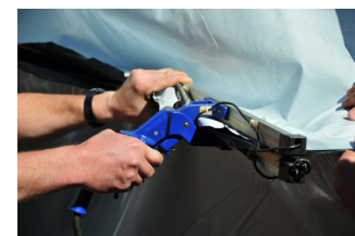
Verschweissen der Ecken mit der Schweißzange.
