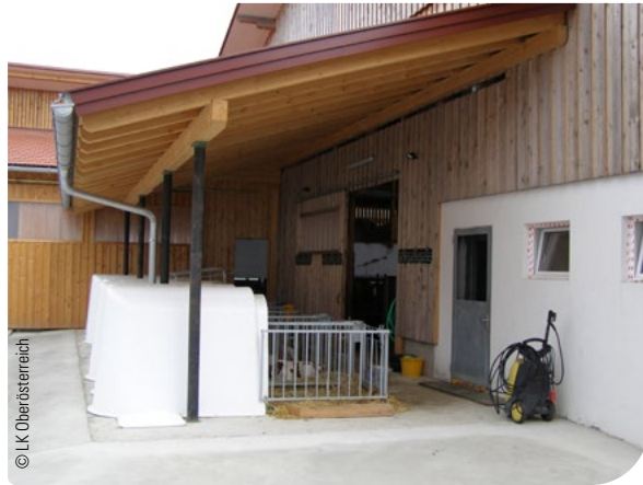
Abb. 35: Iglus sind an einem geschützten Ort aufzustellen. Sie müssen überdacht werden.
